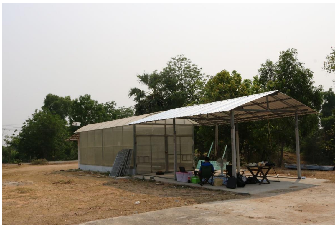
รูปที่ 13 โรงเรือนอบแห้งที่ทำการติดตั้งแผ่นโพลีคาร์บอเนตเสร็จเรียบร้อยแล้ว
