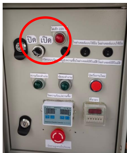
รูปที่ 31 ตำแหน่งปุ่มเปิด-ปิด และหลอดไฟแสดงสถานะการทำงานของชุดควบคุมหลัก
