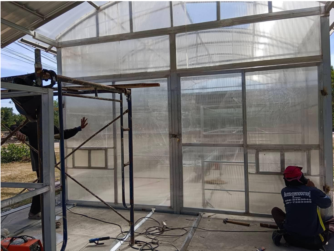
รูปที่ 11 การทำโครงสร้างของโรงเรือนอบแห้ง
