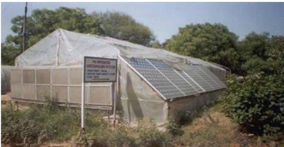
รูปที่ 5 โรงอบแห้งแบบเรือนกระจกที่ติดตั้ง ณ อุทยานพลังงานแสงอาทิตย์ IIT Delhi
