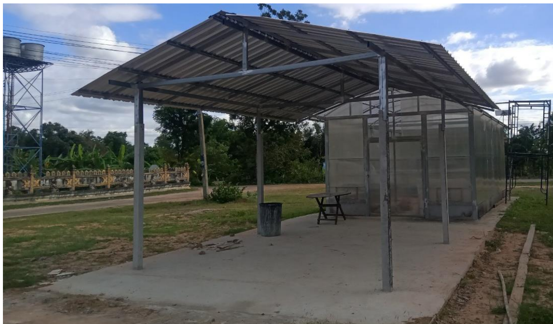
รูปที่ 12 การติดตั้งโครงหลังคายื่นออกจากโรงอบเพื่อเก็บผลิตภัณฑ์
